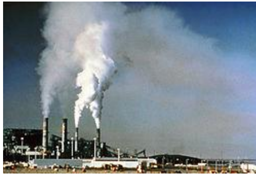
قبل از نصب فیلتر دی اکسید سولفور، مقادیر زیادی دی اکسید سولفور به هوا از این نیروگاه واقع در نیو مکزیکو وارد می‌شد.
